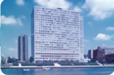
三井倉庫箱崎ビル
